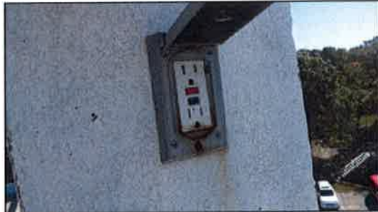
Photo 4 Remove Receptacle
