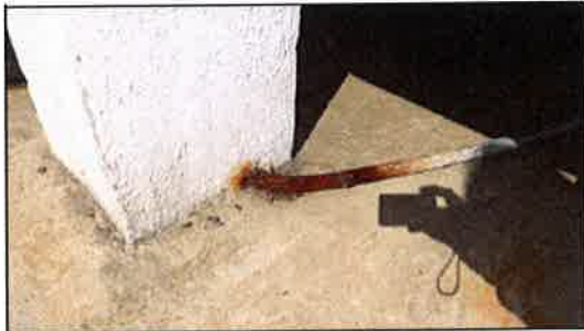
Photo 1 Remove Exposed Conduit
