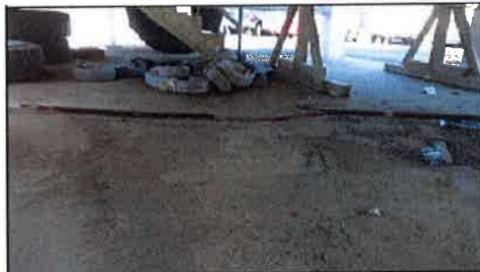
Photo 2 Remove Exposed Conduit
